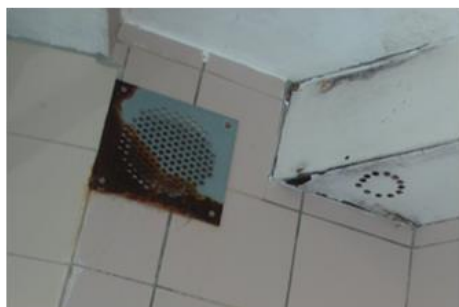
Systèmes anti-vandalismes et plafonds rouillés et dégradés
