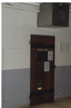
Les menuiseries et les portes ont des traces d'humidité et dégradation
