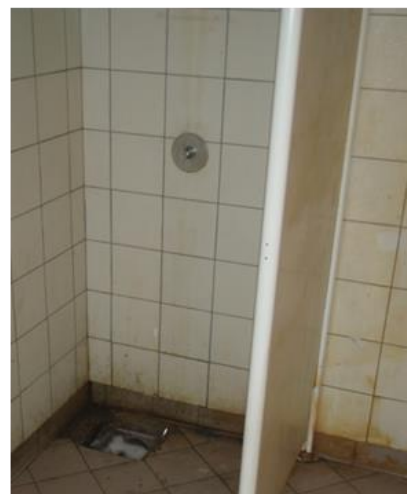
Caniveau à grille manquante ou abimée
