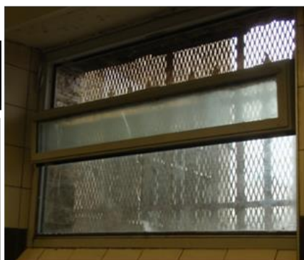
Les menuiseries et les portes ont des traces d'humidité et dégradation
